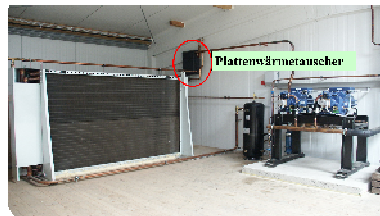
Abb.1: WRG-Standardanlage für Metzgereien, Käsereien, Restaurants etc., wie sie auch in der Metzgerei Salvisberg in Wimmis installiert wurde.
